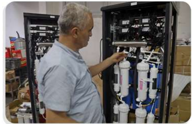
تجهيز محطة تحلية المياه - شركة نادر لولو
